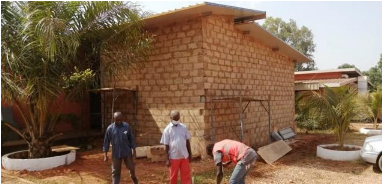
12 gennaio 2021 Ampliamento della palazzina tecnica dell'officina farmaceutica
